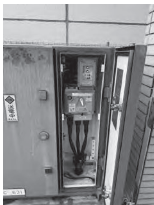
停電試験において技術基準に適合する試験するDGR(地絡方向継電器)付きUGS
