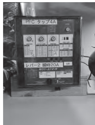
停電試験において技術基準に適合する試験するOCR(過電流継電器)
