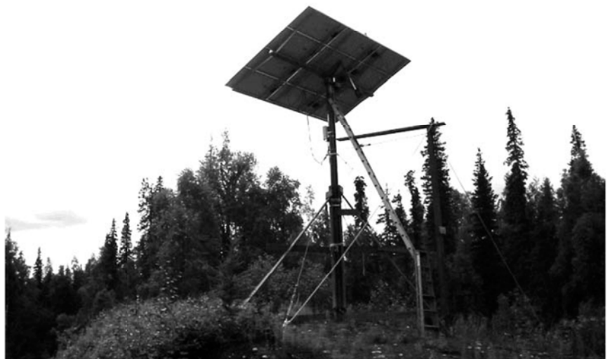
我が家の太陽光エネルギー設備
