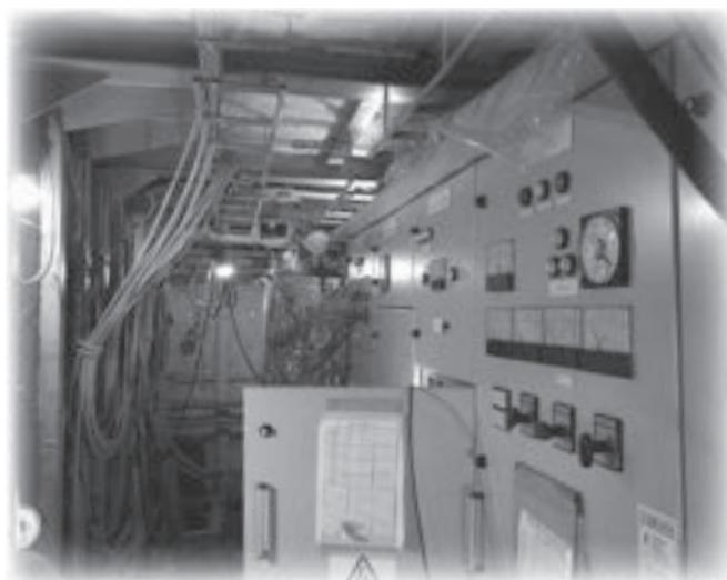
写真5 配電盤室。床・壁・天井はまだむき出しのまま、更に配線工が進みます。
